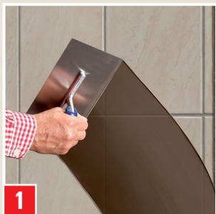
1 Auftrag von FLÄCHENSPACHTEL TURBO auf alten Fliesen zum Egalisieren des Fugenbildes.
